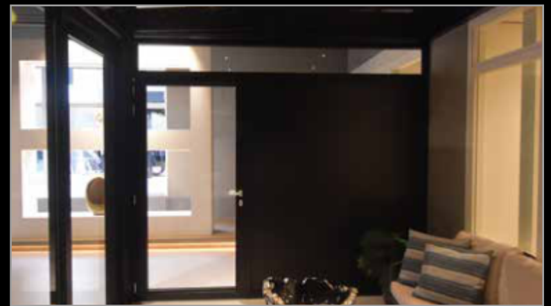
\Aluminiumwand, Glastür und Oberlicht
